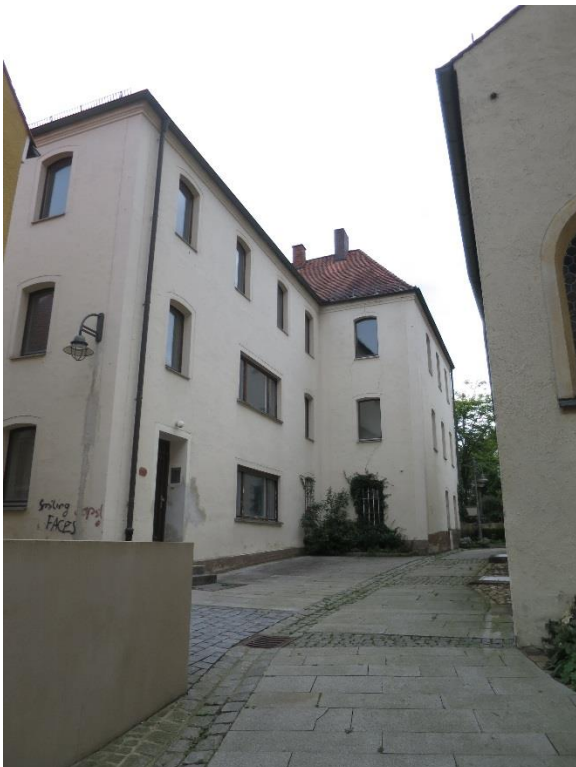
Konventgebäude mit Anbau von 1712 in den ehemaligen Friedhof hinein
