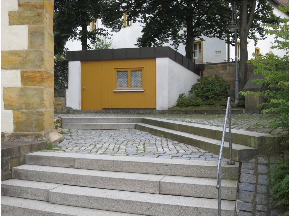
Wirtschaftsgebäude für den Pfarrmesner
