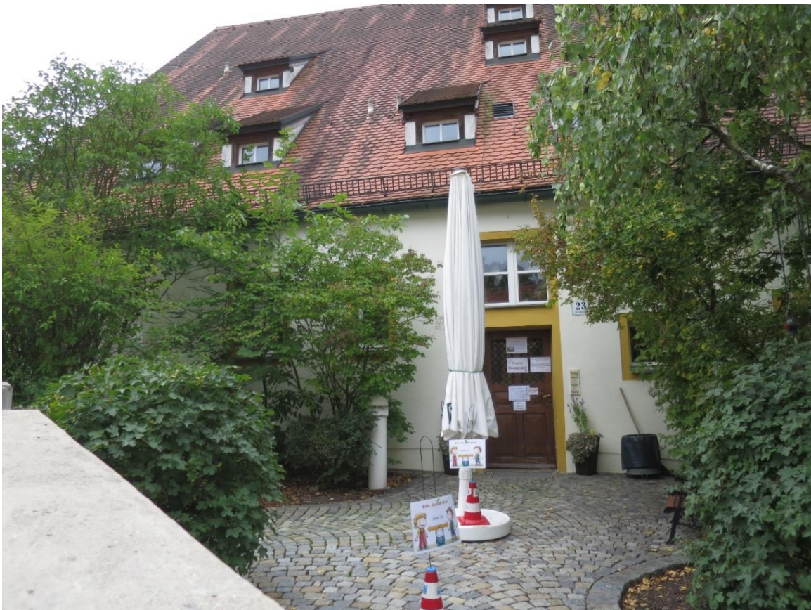
Nördlicher Eingang zum Pfarrhof, jetzt Kindergarteneingang von der Spitzwegstraße aus, vorher Gartentür des Pfarrhofes
