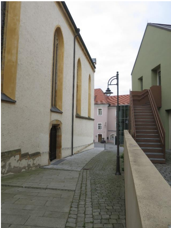
Nördlicher Seiteneingang, am Verlauf der Gartenmauer der Kinderkrippe kann man erkennen wiehoch der Höhenunterschied zwischen Kirchengasse und altem Friedhof war.
