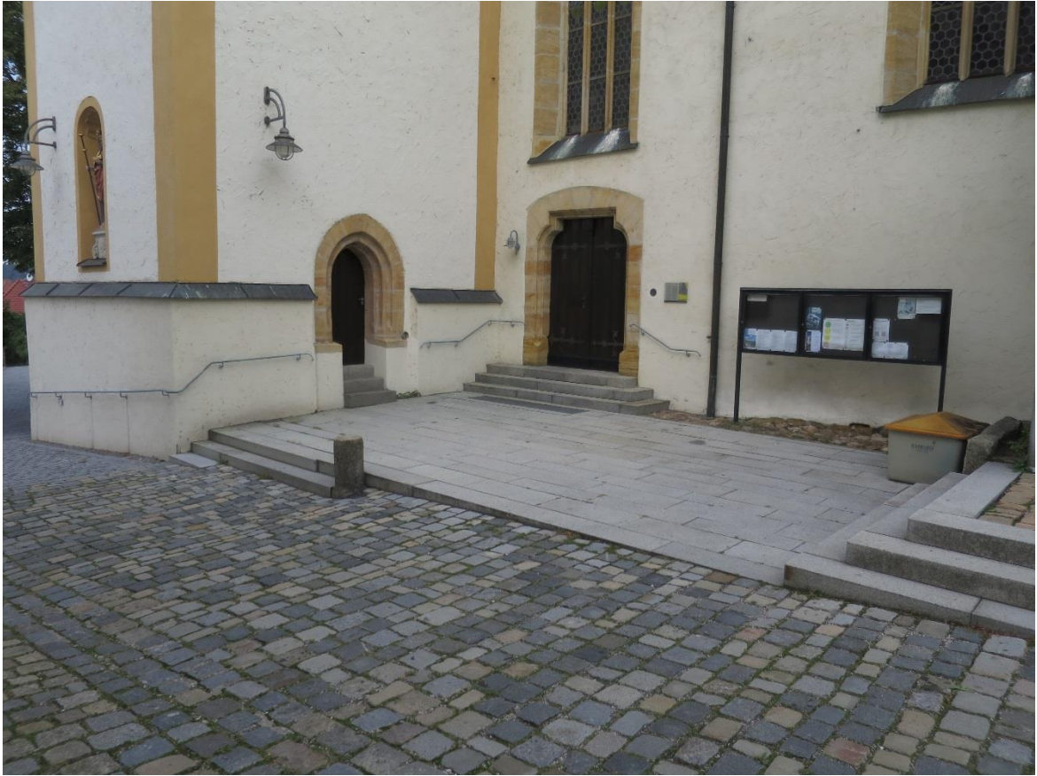
Südlicher Seiteneingang mit Eingang zum Kirchturm
